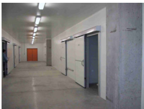
Corridoio ufficio con celle
