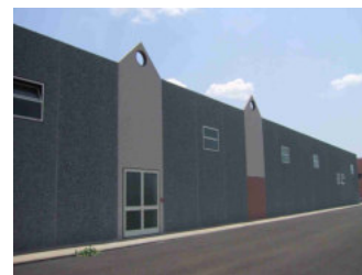
Facciata principale opificio con celle
